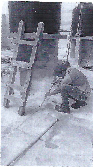
Se limpió la tubería de los tinacos, ya que tenían mucho sarro
