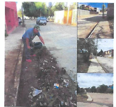
➤ Trabajos de limpieza en espacios urbanos.
